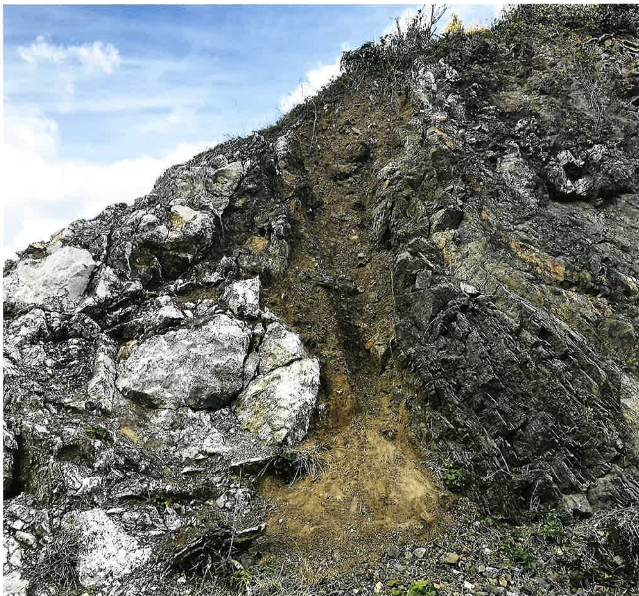
海岸に見られる断層破碎帯（和歌山県日高郡由良町）
